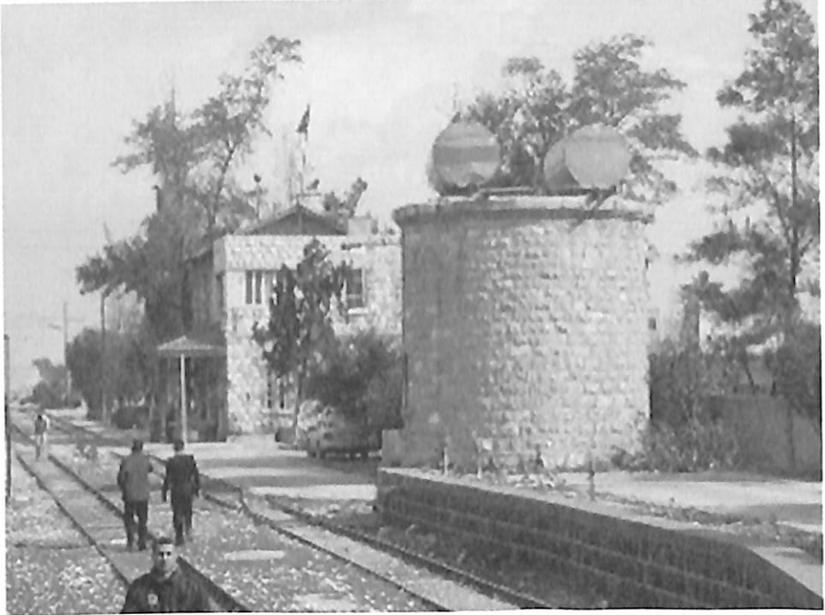
الصورة (٦) : تبين المنصة وخزان المياه والمبنى الإداري في محطة الزرقاء (المصدر : شبكة المعلومات العنكبوتية)
