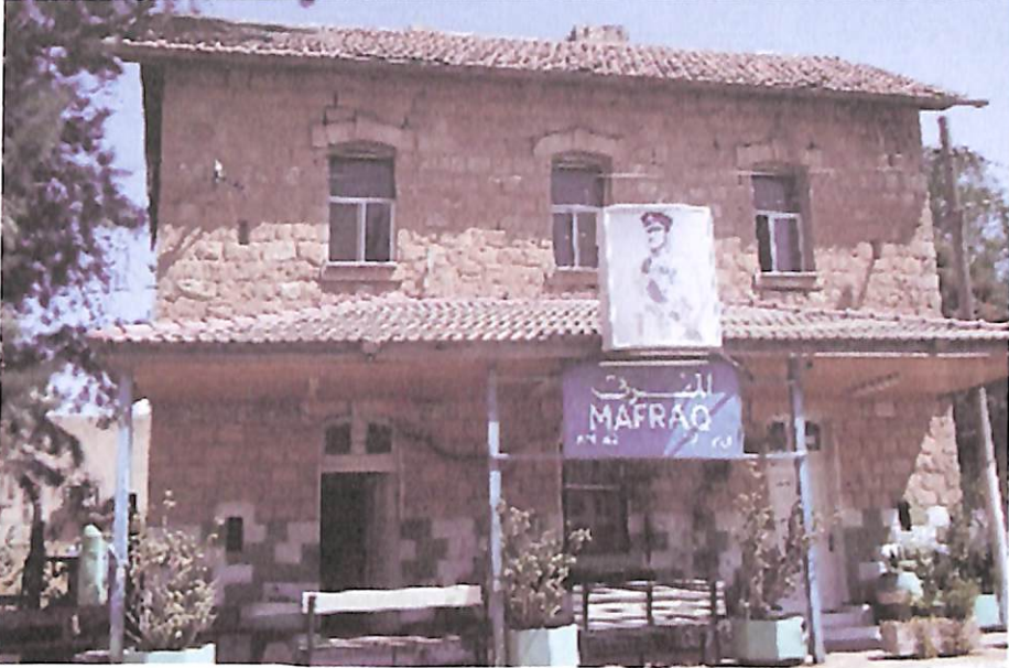
الصورة (١٢) : صورة حديثة للمبنى الرئيس (الإداري) لمحطة المفرق تبين حالته في الوقت الحاضر (المصدر : تصوير الباحث)
