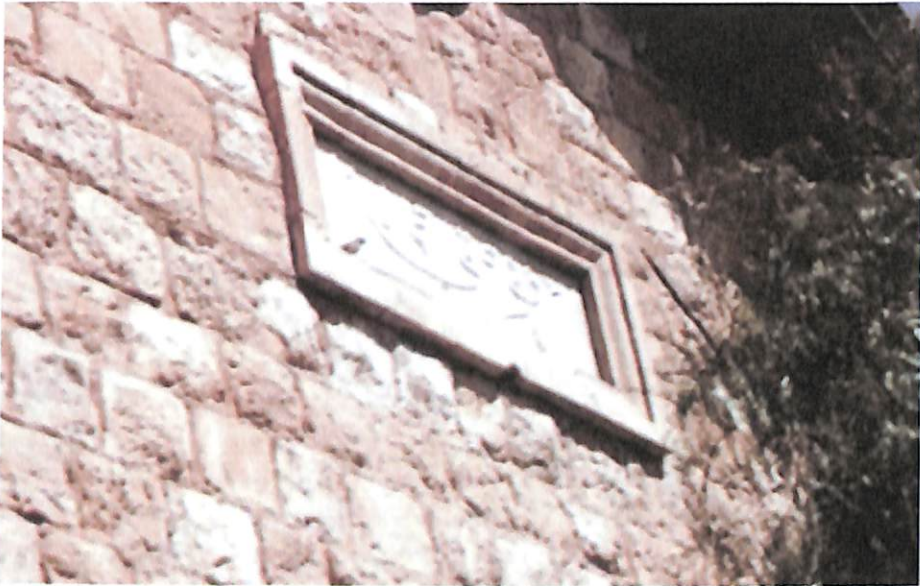
الصورة (١٣) : اللوحة التعريفية بمحطة المفرق (المصدر : تصوير الباحث)
