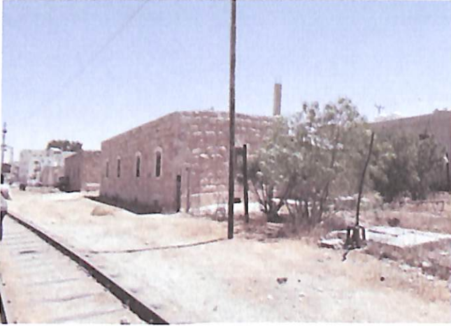
الصورة (٤) : تبين المباني السكنية الخاصة بالعمال والموظفين في محطة المفرق (المصدر : من تصوير الباحث)
