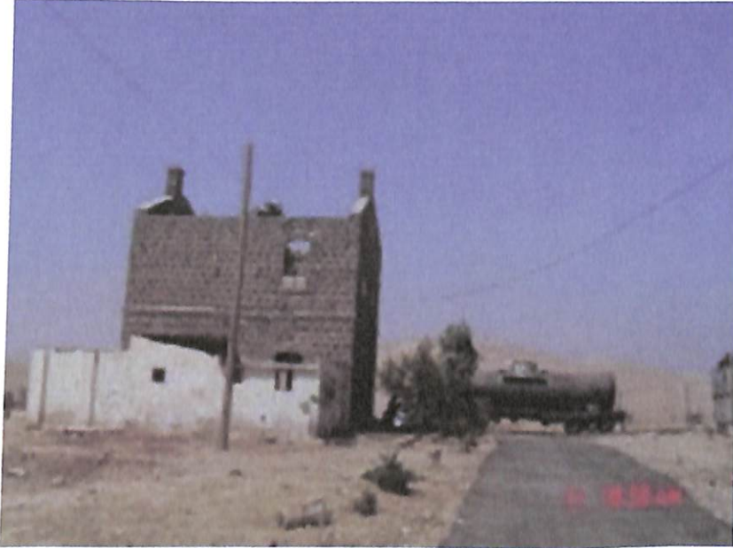
الصورة (١٠) : المبنى الرئيس في محطة الخربة السمرا ، ويظهر فيه واضحاً استخدام الحجر البازلتي الخالص . (المصدر : تصوير الباحث)
