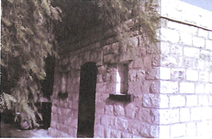
الصورة (١٧) : مبنى المرافق الصحية في المحطة -الجهة الغربية (المصدر : تصوير الباحث)
