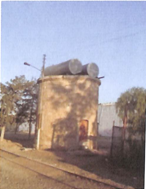
الصورة (١٤) : المبنى الدائري (الخفر) في محطة المرفق (المصدر : تصوير الباحث)
